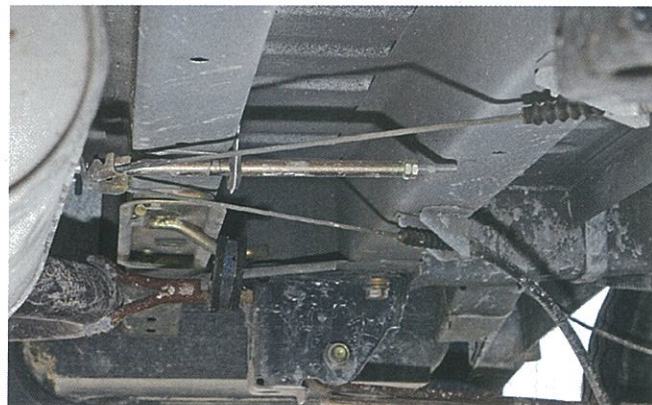
Tension et état des câbles de frein sont à surveiller, pour garantir l'efficacité du circuit de frein sur les roues arrière.
